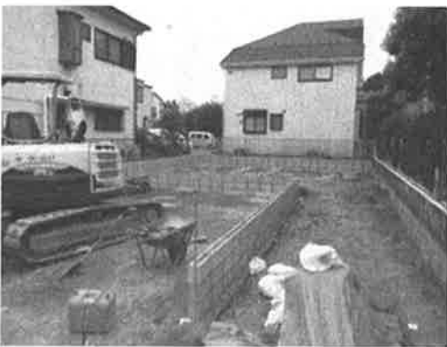
2区画に分けられた建売住宅の開発現場
