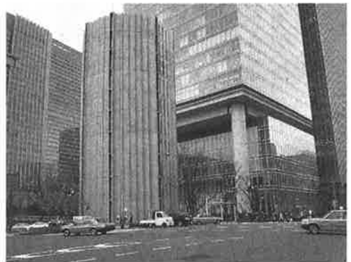
東京駅近くにある既存建物の建て替え現場
